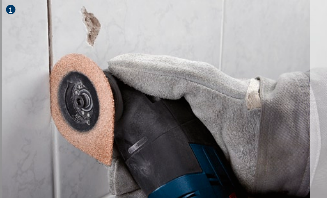
Rezanje fug med stenskimi in talnimi ploščicami.
