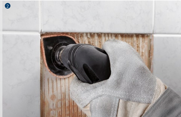
Odstranjevanje malte ali lepila za ploščice – tudi v vogalih.
